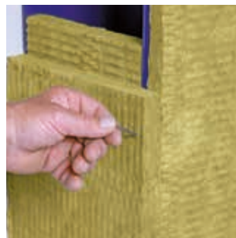
6 Fixieren der Brandschutzbekleidung mit Metallstiften bis der Kleber getrocknet ist (bis zu 12 Stunden).
