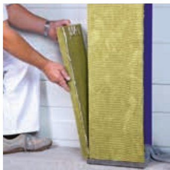
5 Anbringen der Brandschutzbekleidung am Seitenflansch
