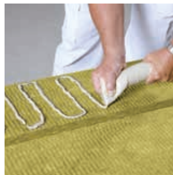
3 Aufbringen des Conlit® Fix auf die Bekleidung (raupenförmiger Auftrag)
