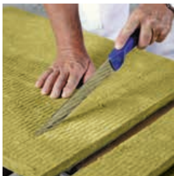
1 Zuschneiden der Platten
